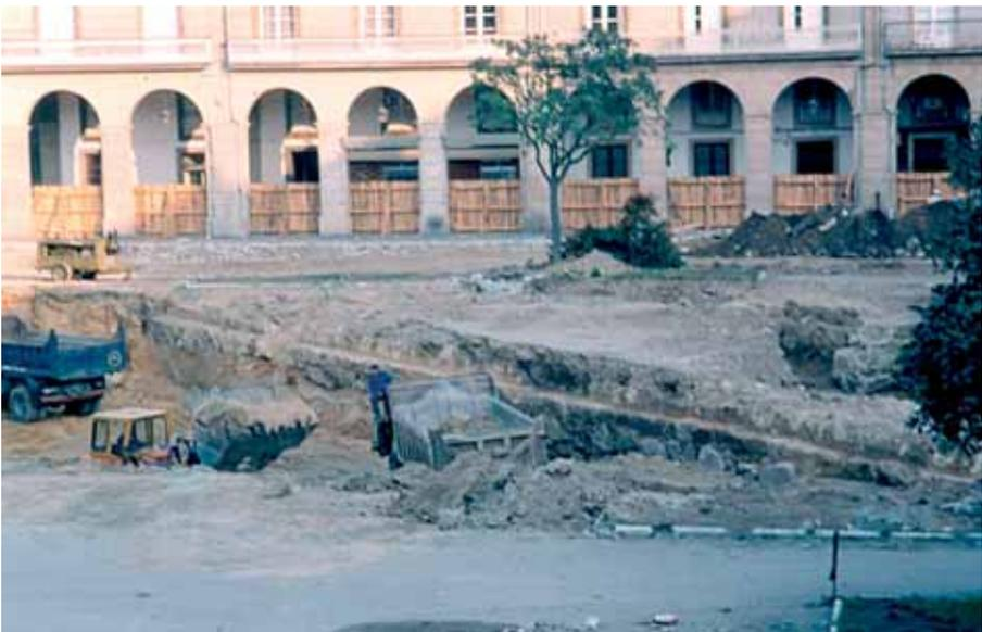
Excavación del aparcamiento en la plaza María Pita, con los restos del las murallas, antes de su demolición.
