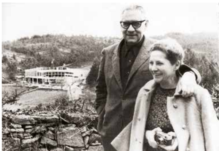
Seoane e Maruxa en Sargadelos, en 1968, coa nave circular en construción ao fondo
