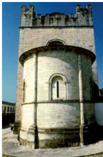
Fachada este. Antes de la modificación de cubiertas en 1986. Archivo Fco. J. Ocaña.
