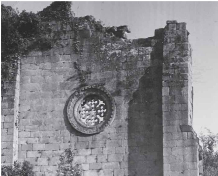
Imagen del remate del hastial norte del transepto a mediados de los 60. Permanecería en este estado hasta las primeras obras de consolidación realizadas por la escuela taller en 1990. Fuente: M.P. Autor desconocido.
