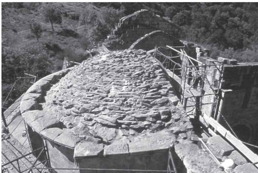
Imagen de la bóveda de la cabecera totalmente descarnada durante los trabajos de consolidación e impermeabilización llevados a cabo por Baltar, Bartolomé y Almuiña a principios de los años 90. Fuente: Márgen S.L. Autor: Tino Viz.
