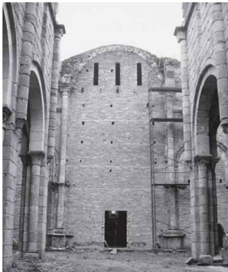
Imagen de la cimbra de ladrillo construida en la cabecera durante la primera fase de las obras de rehabilitación dirigidas por Enrique Barreiro. 1992. Fuente: Márgen S.L. Autor: Tino Viz.
