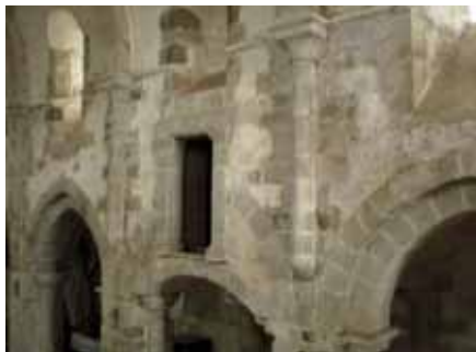
Fotografía del interior de la iglesia en la que podemos ver el antiguo paso del claustro al coro alto y el rebaje que produjo su construcción en el arco. Fotografía propia, 2010.
