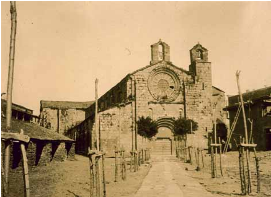
Vista de la fachada principal de la iglesia de Santa María. A la derecha podemos observar parte del monasterio en estado ruinoso, apuntalado, y a la izquierda los puestos de venta. (Arxiu Mas, copia en papel sin referencia).
