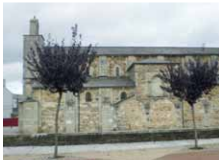
Fotografía en la que se observa el cambio de piedra en los paños de los dos primeros tramos a la altura en la que estaría la última arcada. Fotografía propia, 2010.
