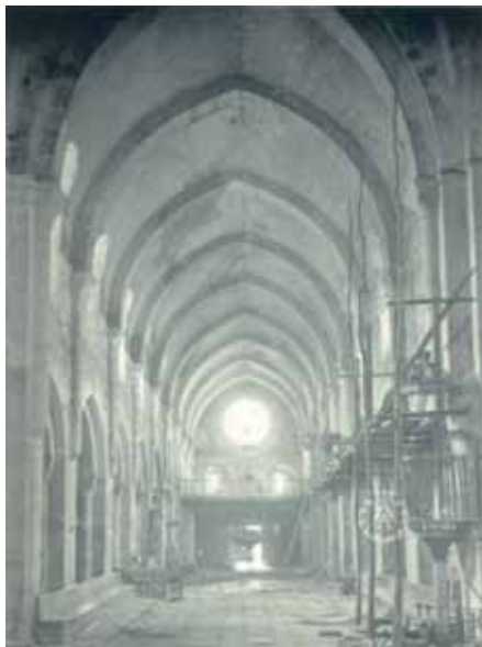
Fotografía de la nave principal de la iglesia mirando hacia los pies, donde se aprecia el andamiaje elemental para limpiar de cal los paramentos. (COAC Arxiu Ferrant sign. 283).
