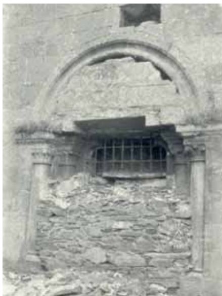
Demolición de la puerta de comunicación del crucero con el claustro, desde el exterior. (COAC Arxiu Ferrant sign. 289).
