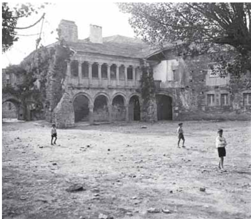
Vista de los restos del claustro renacentista o de la Hospedería, entre los años 20 y 40, que aún se conservan hoy en día, con la entrada a la izquierda. Se puede apreciar la inexistencia de la panda norte, reconstruida en la actualidad, con una piedra diferente a la original. (Arxiu Mas, sign. Almató E-4441).
