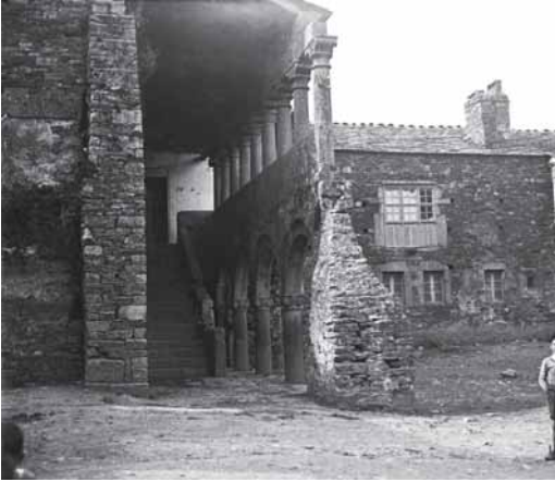
Fotografía, tomada entre los años 20 y 40, que nos muestra los restos del claustro de la Hospedería, en situación ruinoso, las escaleras por las que se accedía a la parte alta, el estado de las nuevas dependencias de la parte norte y el gran espesor de los muros. (Arxiu Mas, sign. Almató E-4442).
