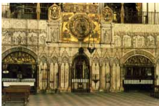
Fig. 3. Lado oeste de la cerca exterior del coro, catedral de Toledo.
