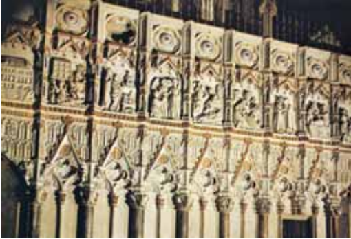
Fig. 4. Lado sur de la cerca exterior del coro, catedral de Toledo.
